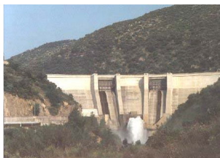
Photographie 3. Vue à l'aval du barrage de Vinça.
