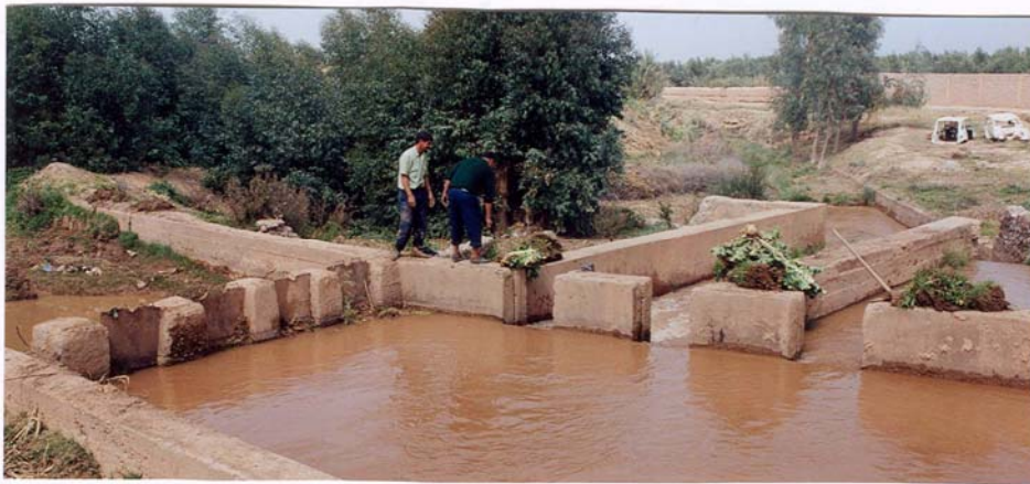
Photo II-2 : Installation des végétaux et mottes près des dérivations à obturer
