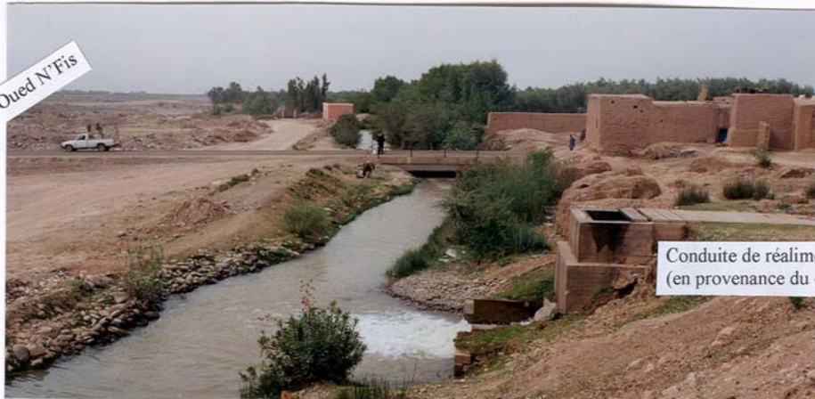
Photo I-1 : Réalimentation d'une seguiya par les eaux du barrage Lalla Takerkoust
