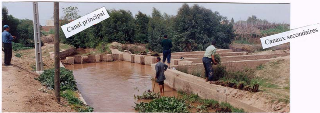
Photo II-1 : Découpe de végétaux et de mottes d'herbe Des vannes obturent le canal principal – l'eau est dérivée dans un canal secondaire
